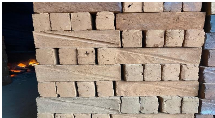
Gambar 8 Batu Bata Selama Pembakaran Berada Di Paling Atas
